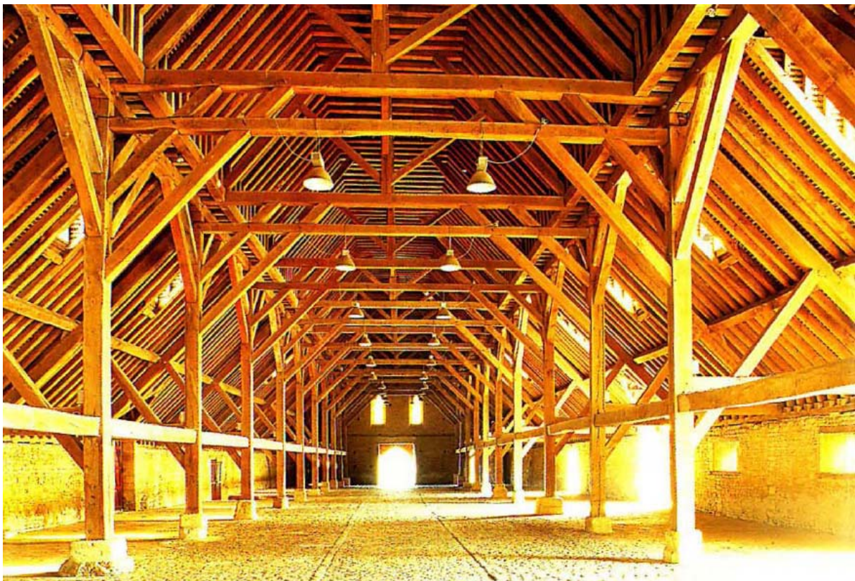
Bild 2: Die im Jahre 1944 abgebrannten Markthallen von Saint-Pierre-sur-Dives wurden mit den Materialien und nach denselben Verfahren des 11. und 12. Jh. wieder aufgebaut.
